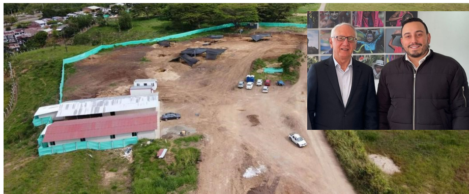
Salvar la construcción del Hospital de Cuarto Nivel es el reto más importante que tiene el nuevo gobernador de Risaralda. Ya inició gestiones con el Ministro de Salud Guillermo Alfonso Jaramilo. (Foto: Pulso.com—Oficina de prensa Patiño Gobernador)
